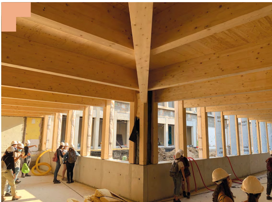
Visite de chantier
